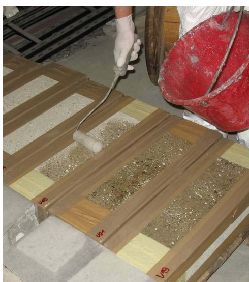
Figura 1: Fase di impregnazione delle superfici di calcestruzzo mediante primer.
